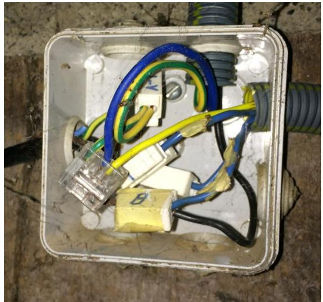
4. Rupture du neutre à cause d'un mauvais serrage dans une borne, un sectionneur de neutre défectueux, cela provoque la mise sous tension des parties métalliques des appareils.
